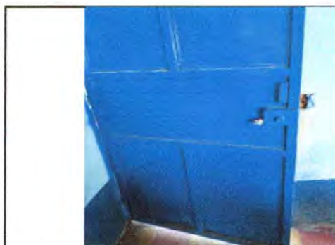
Foto 3: Sustitucion de chapa.
